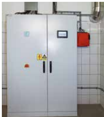
... i upravljački ormar u kotlovnici
