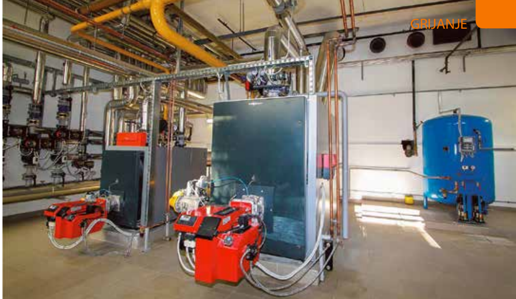
... i niskotemperaturni kotlovi Viessmann Vitoplex 200
